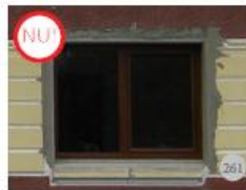
Fig. 261. ASA NU: Fereastră cu proporții specifice „casei TIP” 1960. NU se recomandă schimbarea numărului de canaturi.
