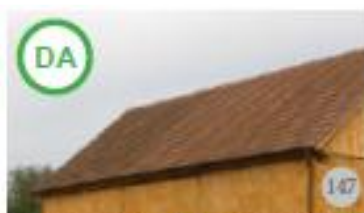
Fig.147, 148. AȘA DA: Țigla ceramică tradițională sau industrială și-au dovedit durabilitatea, chiar de peste 100 de ani în cazul celor produse manual, iar o parte dintre plese sunt înscrispionate și au forme unice. Se recomandă completarea învelitorilor ce au țigle lipsă și re folosirea țiglelor în stare bună, chiar și în cazul unor construcții noi sau construcții asupra cărora se înțreprend renovări. Se pot țese alternat țigle noi și vechi. (Drăguș, jud. Brașov)
