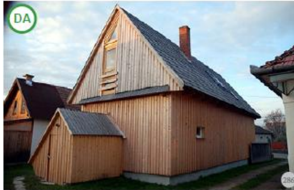
Fig. 286. AȘA DA: Exemplu în care lemnul este folosit simplu, durabil și onest. Folosirea unor forme esențializate ale arhitecturii vernaculare, precum frontonul plăc cu lemn din imagine, poate fi de bun augur pentru încurajarea păstrării specificului local. Se recomandă ca asemenea frontoane să nu fie confecționate din lambruri de PVC și pentru execuție, să se apeleze la o echipă de meșteri locali.
