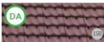
Fig.150. AȘA DA: Țigla ceramică trasă industrială poate fi folosită, dacă respectă forma și dispunerea tradițională.
