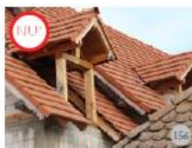
Fig.156. AȘA NU: Folosirea unei țigle care o imită pe cea ceramică (țigle din beton, tablă etc.) are un efect contrastant cu învelitoarea istorică din imagine.
