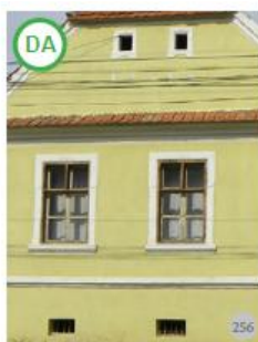
Fig. 255. 256. Ferestre istorice într-o singură foaie de geam, cu un singur strat de sticlă (Ohaba, jud. Brașov)
