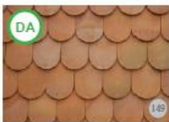
Fig.149. AȘA DA: Țiglă nouă tip solzi produsă manual în tehnica tradițională pentru clădiri noi și reabilitări de clădiri vechi.
