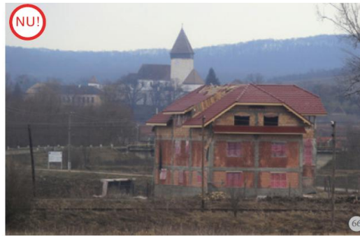
Fig.66. AȘA NU: Amplasarea unei clădiri în afara vetrei satului, sau chiar în intrarea în sat, care nu respectă încadrarea în peisaj și materialele naturale locale ca element dominant este interzisă, ea având un efect distrugător asupra peisajului și a percepției asupra întregii așezări.
