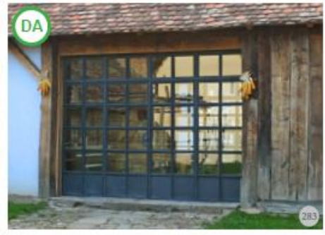
Fig. 283. AȘA DA: Înlocuirea în trecut a unor ferestre pentru funcțiuni precum baia, mansarda, restaurantul etc., poate lăsa loc liber unei abordări creative în acest domeniu.
