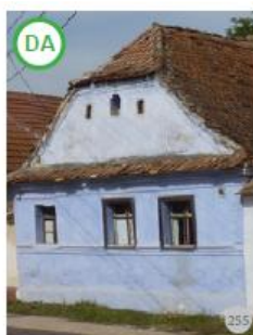
Fig. 255. 256. Ferestre istorice într-o singură foaie de geam, cu un singur strat de sticlă (Chaba, jud. Brașov)
