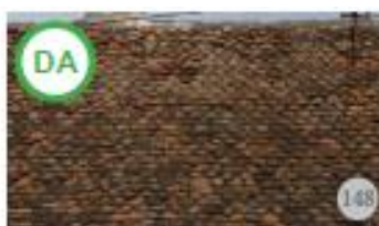
Fig.147, 148. AȘA DA: Țigla ceramică tradițională sau industrială și-au dovedit durabilitatea, chiar de peste 100 de ani în cazul celor produse manual, iar o parte dintre plese sunt inscripționate și au forme unice. Se recomandă completarea învelitorilor ce au țigle lipsă și refolosirea țiglelor în stare bună, chiar și în cazul unor construcții noi sau construcții asupra cărora se înțrepește renovări. Se pot face alternanțe țigle noi și vechi. (Drăguș, jud. Brașov)
