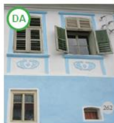
Fig. 262. ASA DA: Fereastră cu un strat de geam dublat de un oblon – soluție pentru perioada de vară. În timpul iernii, se schimbă oblonul cu un strat de ferestre, pentru o termoizolare mai bună (Roadeș, jud. Bășov)
