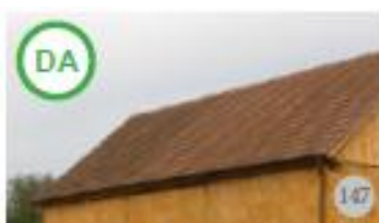
Fig.147, 148. AȘA DA: Țigla ceramică tradițională sau industrială și-au dovedit durabilitatea, chiar de peste 100 de ani în cazul celor produse manual, iar o parte dintre plese sunt inscripționate și au forme unice. Se recomandă completarea învelitorilor ce au țigle lipsă și refolosirea țiglelor în stare bună, chiar și în cazul unor construcții noi sau construcții asupra cărora se înțrepește renovări. Se pot face alternanțe țigle noi și vechi. (Drăguș, jud. Brașov)
