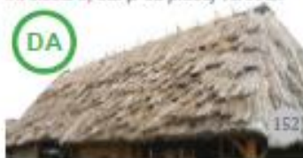
Fig.152. AȘA DA: Snopii din pale de secară erau folosiți în mod tradițional pentru realizarea învelitorilor, fiind un material natural, cu o durată lungă de viață atunci când se respectă panta specifică zonei pentru acest material.
