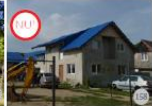
Fig.157, 158. AȘA NU: Vor fi evitate înveltoarele în culori stridente din tablă sau din beton, care nu au o durată lungă de viață.
