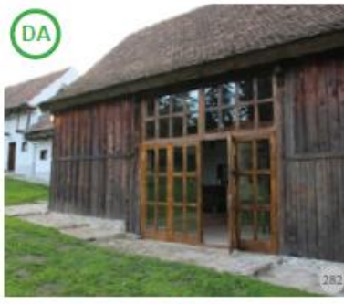
Fig. 278, 279, 282, 283. AȘA DA: Înlocuirea în trecut a unor ferestre pentru funcțiuni precum baia, mansarda, restaurantul etc., poate lăsa loc liber unei abordări creative în acest domeniu.
