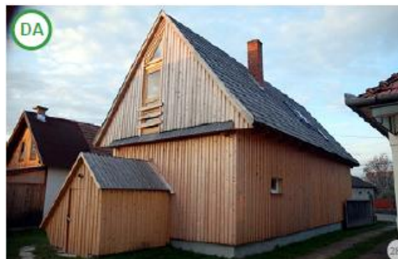
Fig.286. AȘA DA: Exemplu în care lemnul este folosit simplu, durabil și onest. Folosirea unor forme esențializate ale arhitecturii vernaculare, precum frontonul plăt cu lemn din imagine, poate fi de bun augur pentru încurajarea păstrării specificului local. Se recomandă ca asemenea frontoane să nu fie confecționate din lambriu de PVC și pentru execuție, să se apeleze la o echipă de meșteri locali.
