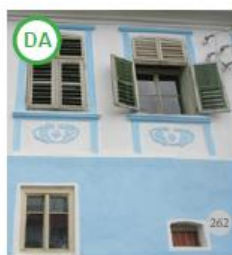
Fig. 262. ASA DA: Fereastră cu un strat de geam dublat de un oblon – soluție pentru perioada de vară. În timpul iernii, se schimbă oblonul cu un strat de ferestre, pentru o termoizolare mai bună (Roadeș, jud. Brașov)
