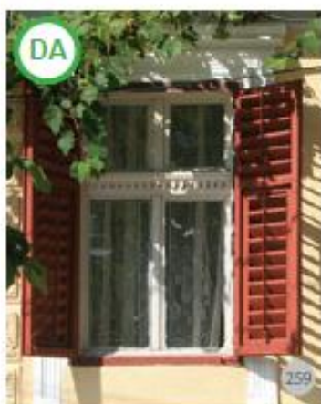
Fig. 259. ASA DA: Fereastră cu un singur geam, dublat de obloane, având traversa decorată.
