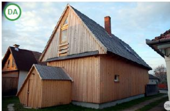
Fig. 286. AȘA DA: Exemplu în care lemnul este folosit simplu, durabil și onest. Folosirea unor forme esențializate ale arhitecturii vernaculare, precum frontonul plăc cu lemn din imagine, poate fi de bun augur pentru încurajarea păstrării specificului local. Se recomandă ca asemenea frontoane să nu fie confecționate din lambriu de PVC și pentru execuție, să se apeleze la o echipă de meșteri locali.
