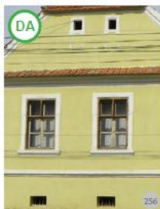
Fig. 255, 256. Ferestre istorice într-o singură foaie de geam, cu un singur strat de sticlă (Ohabia, jud. Bășov)
