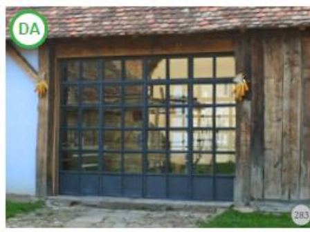
Fig. 283. AȘA DA: Înlocuirea în trecut a unor ferestre pentru funcțiuni precum baia, mansarda, restaurantul etc., poate lăsa loc liber unei abordări creative în acest domeniu.
