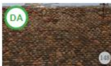
Fig.147, 148. AȘA DA: Țigla ceramică tradițională sau industrială și-au dovedit durabilitatea, chiar de peste 100 de ani în cazul celor produse manual, iar o parte dintre plese sunt înscrispionate și au forme unice. Se recomandă completarea învelitorilor ce au țigle lipsă și re folosirea țiglelor în stare bună, chiar și în cazul unor construcții noi sau construcții asupra cărora se înțreprend renovări. Se pot țese alternat țigle noi și vechi. (Drăguș, jud. Brașov)
